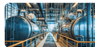
ボイラー用燃料 工場や施設のボイラーで使用されます。
